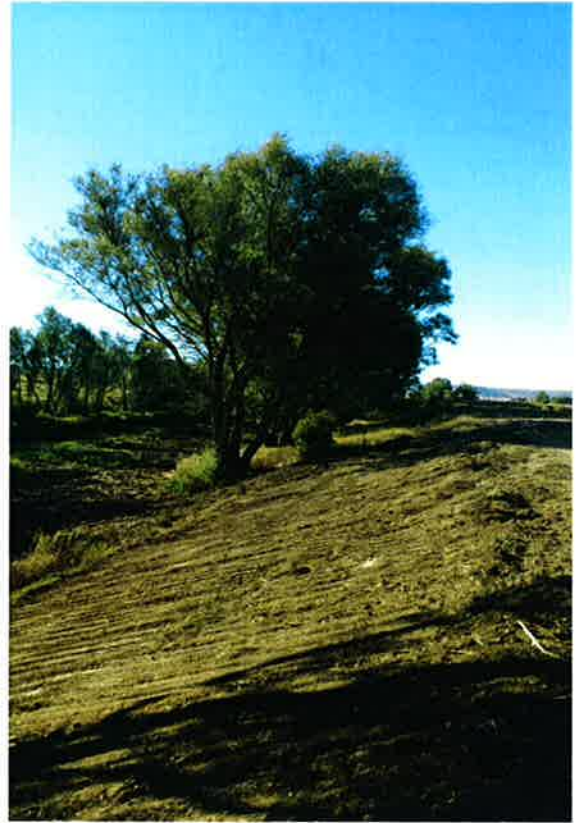
Estación 24. Estado del talud posterior al perfilado.
