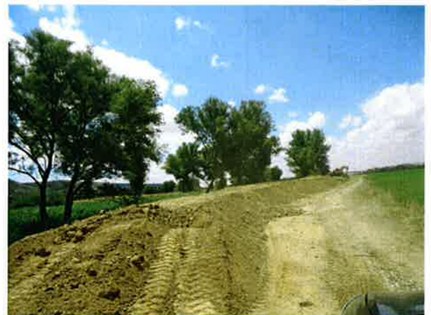
Estación 7. Mota junto al camino finalizada.
