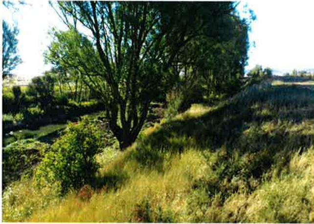
Estación 24. Estado del talud previo al perfilado.
